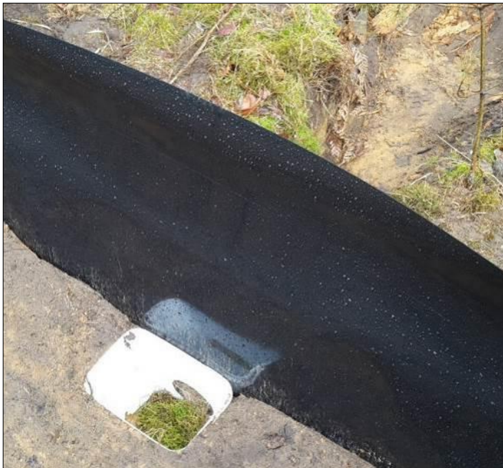
Abb. 13: Beispiel für einen Reptilien-Schutzzaun mit Fluchweg
