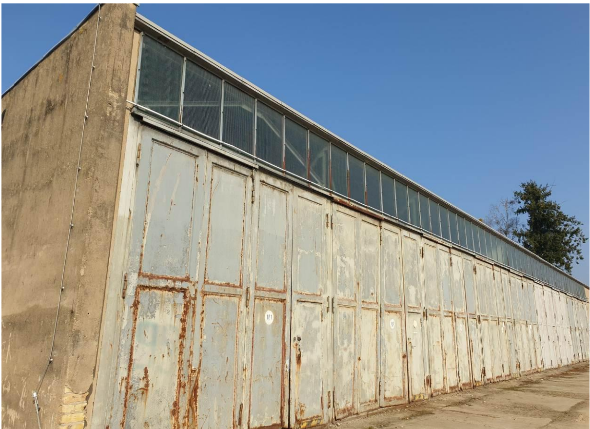
Abb. 18: abzureißende Halle (Gebäude-Nr. 011) im Bereich der Planstraße B (Foto: Grünspektrum, 10.03.2026)
