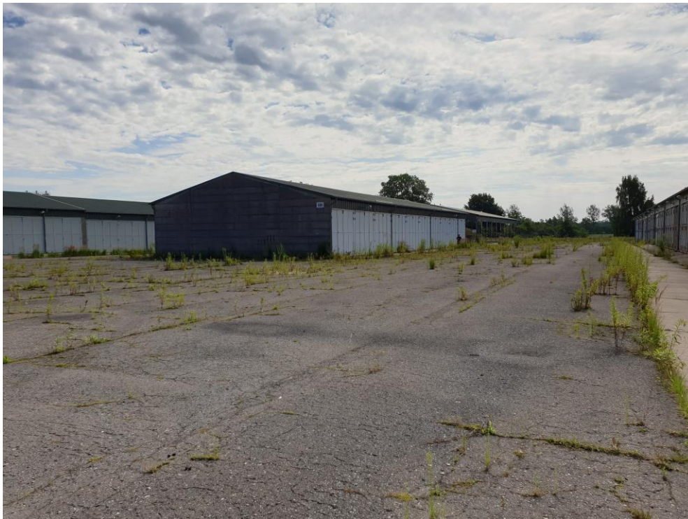
Abb. 4: Beispiel Gebäude und Infrastruktur auf ehem. Bundeswehrgelände
