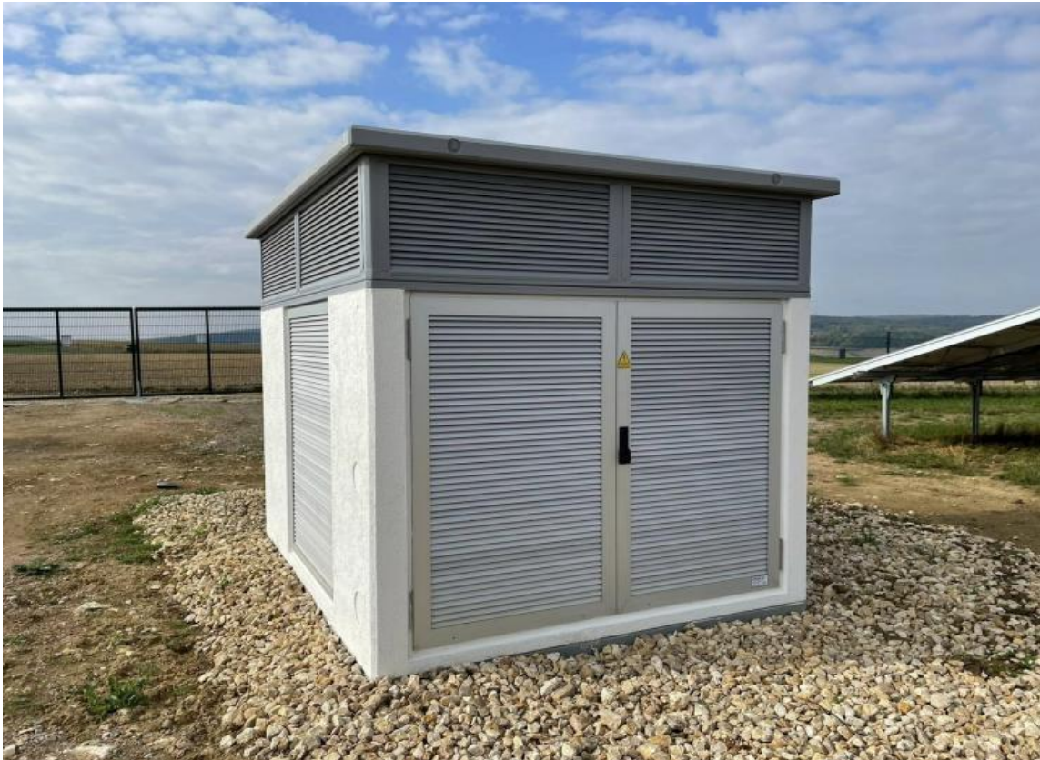
Abbildung 16: Beispiel Transformatoren-Kompaktstation auf Schottertragschicht (Quelle: Fa. Sandmeyer)
