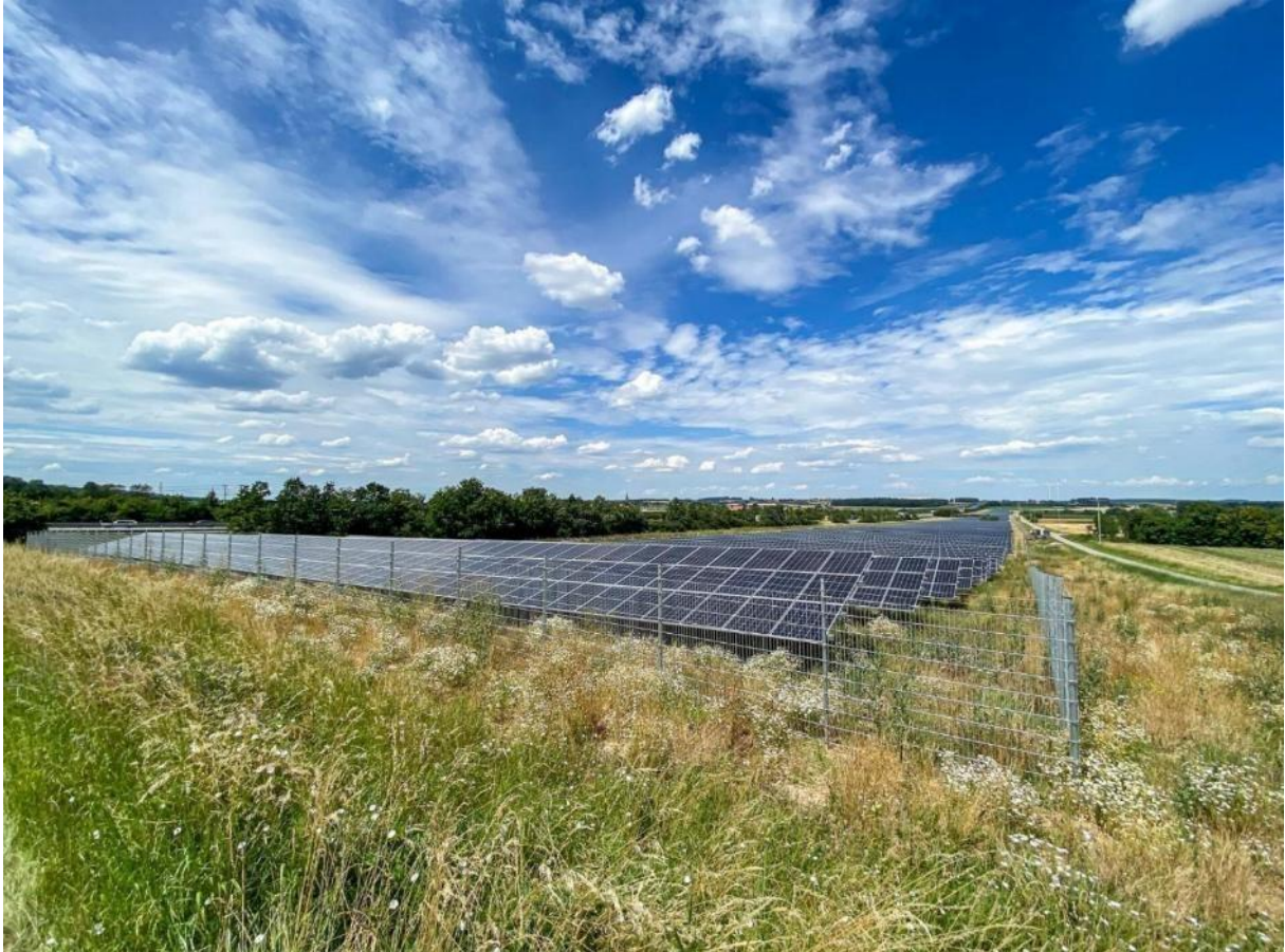
Abbildung 19: Beispiel Einfriedung einer Photovoltaik-Freiflächenanlage (Quelle: EE-Plan, April 2020)
