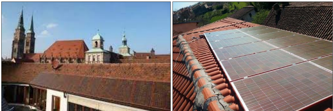
Abbildung 3-7: Rote Photovoltaikmodule 32 33
