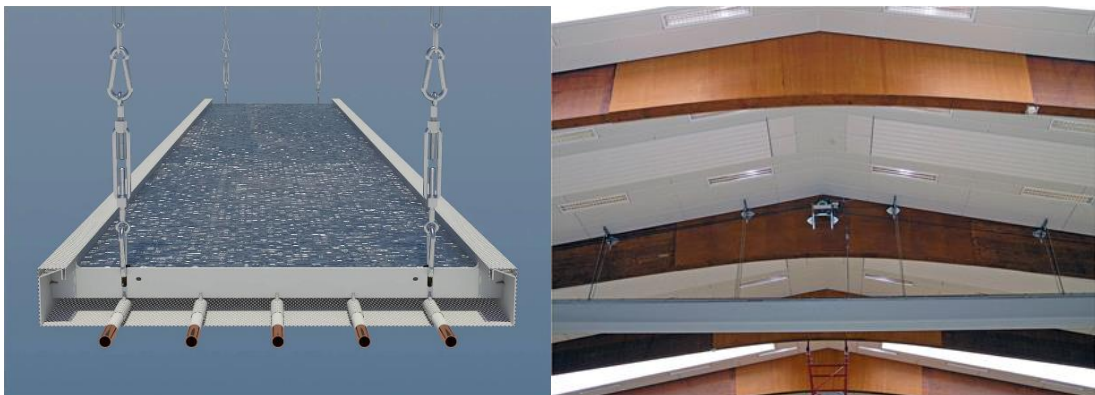
Abbildung 5-3: Deckenstrahlplatten 65
