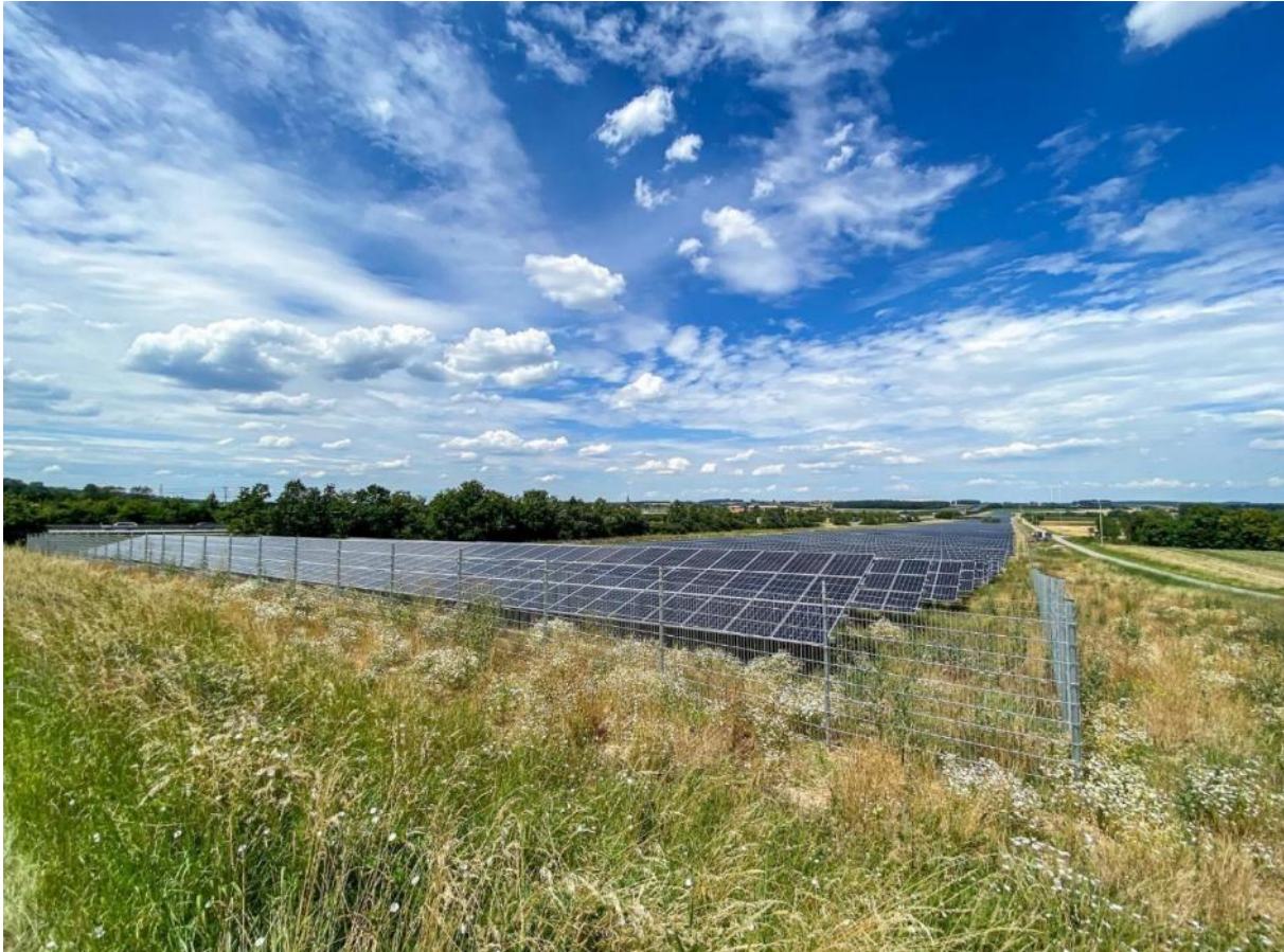
Abbildung 19: Beispiel Einfriedung einer Photovoltaik-Freiflächenanlage (Quelle: EE-Plan, April 2020)
