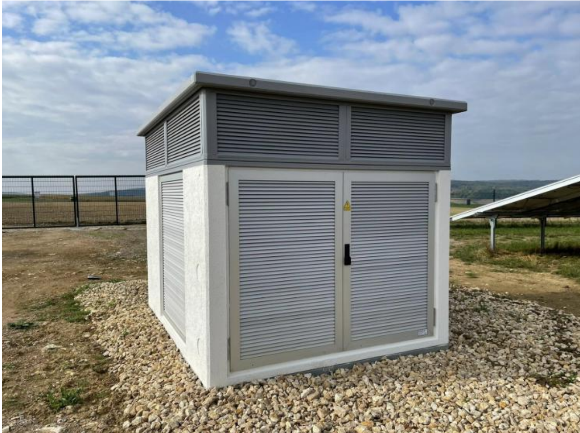
Abbildung 16: Beispiel Transformatoren-Kompaktstation auf Schottertragschicht (Quelle: Fa. Sandmeyer)
