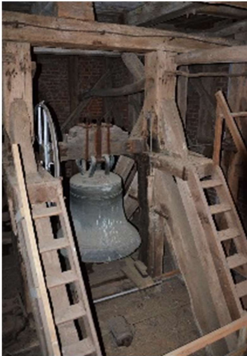
Bockstreben-Glockenstuhl datiert auf 1395/96 (d) im Kirchturm von St. Nikolai Röbel
