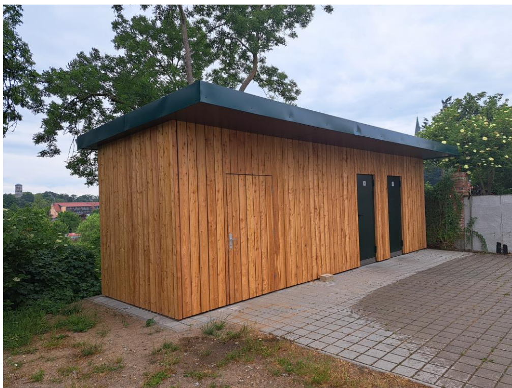
Foto 5 Gestaltungsbeispiel Fassadenbekleidung mit einer unbehandelten Schalung aus Lärchen-Holz.
