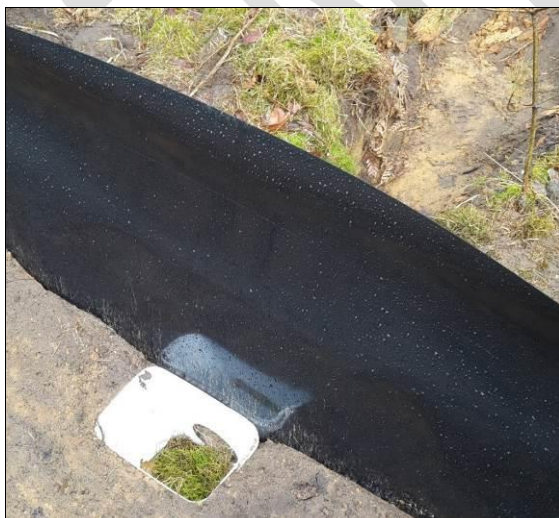
Abb. 22: Beispiel für einen Reptilien-Schutzzaun mit Fluchweg
