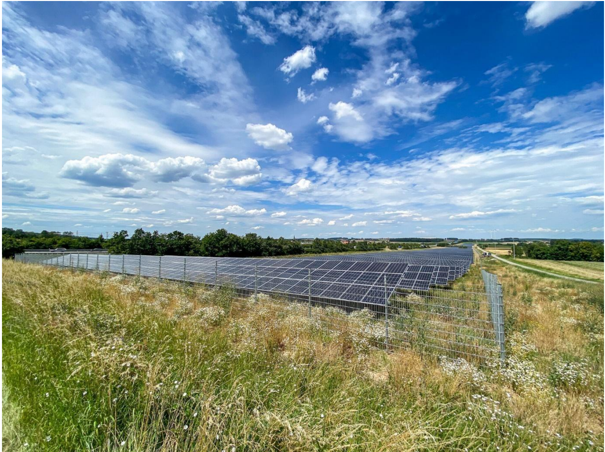
Abb. 14: Beispiel Einfriedung einer PV-FFA (Foto: EE-Plan, April 2020)
